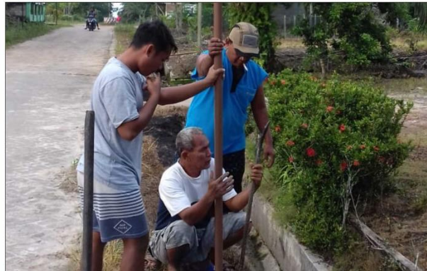
PEMASANGAN TIANG LAMPU JALAN LINGKUNGAN
